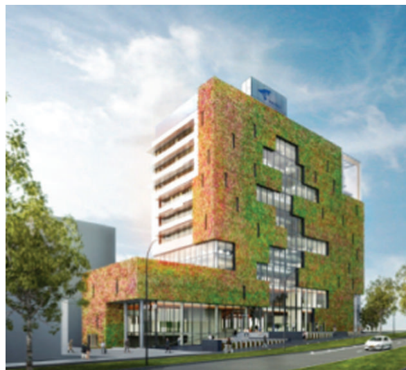
FIGUR 10. Venlo City Hall är byggd i enlighet med Cradle to Cradle-principerna.
